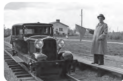
År 1873 öppnades Hjo-Stenstorps järnväg. Den var då den första 891mm smalspårsjärnvägen av betydelse i Sverige. Epoken kom att vara i över 90 år.
