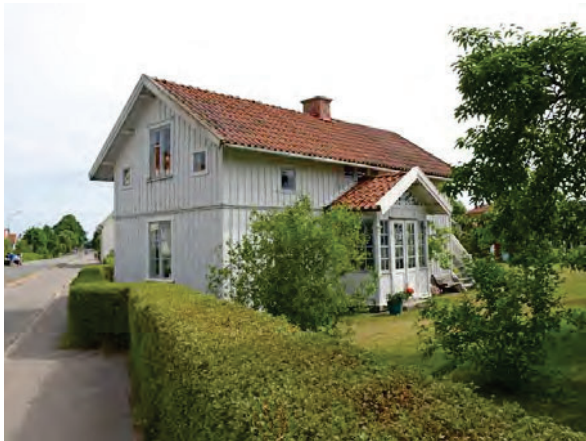
Kråkan 8, om- och påbyggt 1898.
