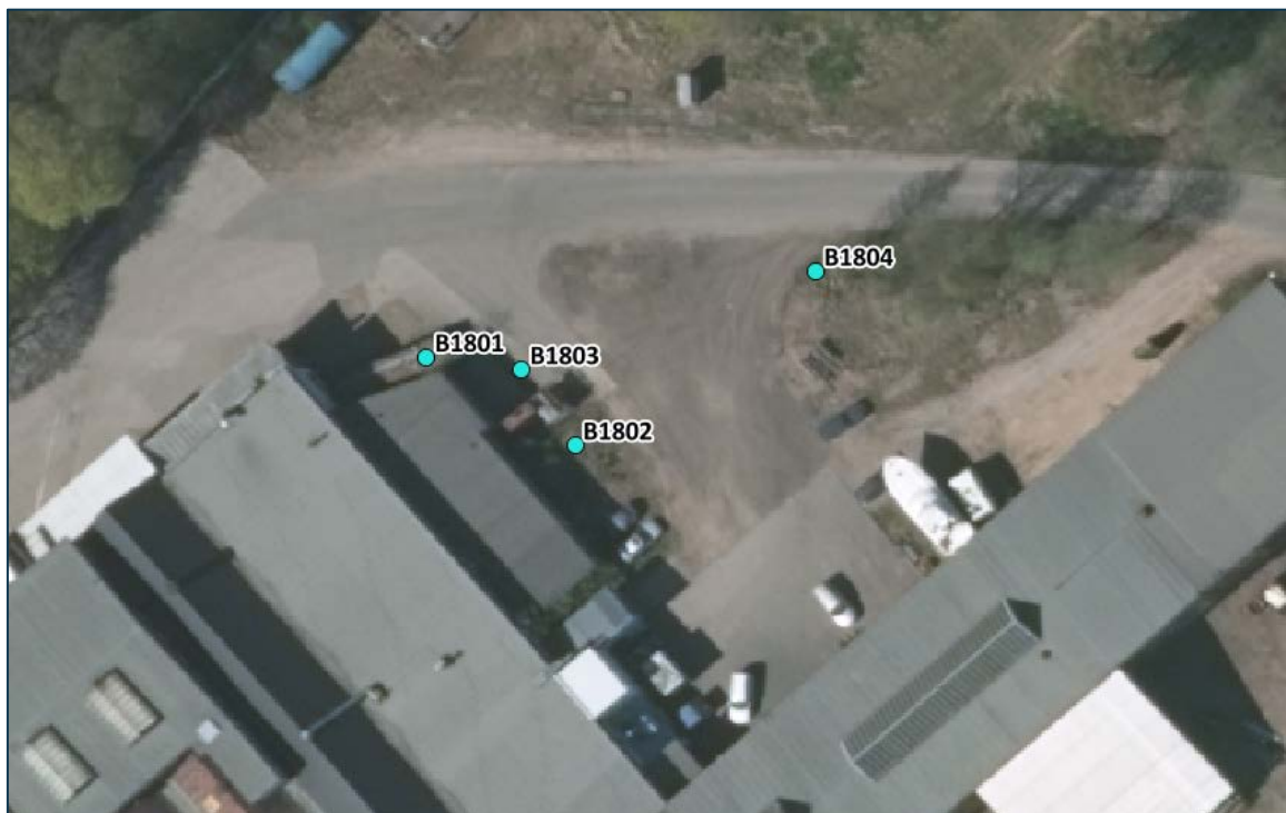
Figur 5. Grundvattenrör installerade 2018. I B1804 återfanns inget vatten.
