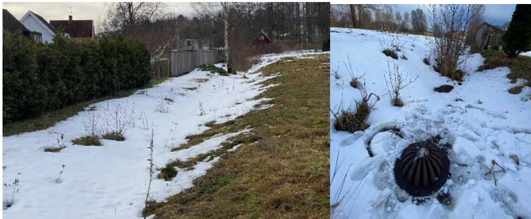
Figur 9. Dike nordväst om fastigheter vid Bokgatan, samt kupolbrunn i sydvästra delen av diket.
