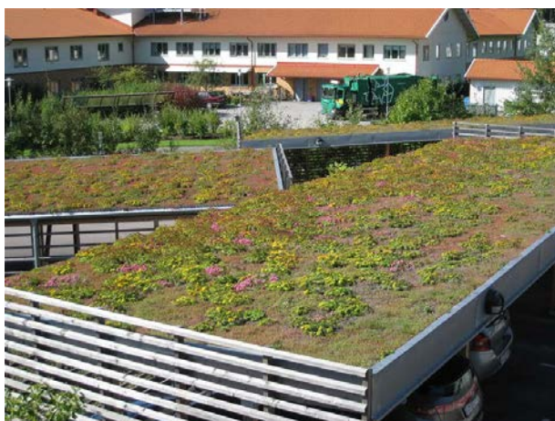
Figur 33. Grönt sedumtak på garagebyggnad i Kungsbacka. Bildkälla: VegTech AB.
