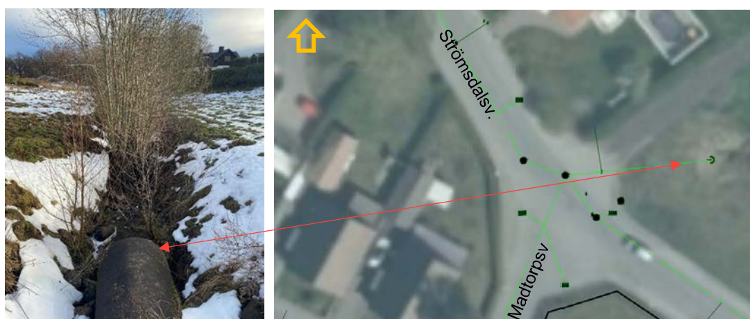
Figur 12. Utlopp från ledningsnät till dike vid Madtorpsvägen.
