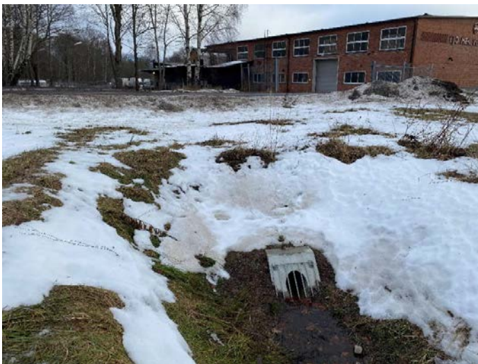
Figur 8. inlopp till dagvattenledning från delområde 1. I bakgrunden Strömsdalsvägen och Hjo mekaniska verkstad.
