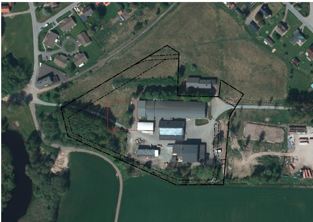
Planområdet och egenskapsgränser som reglerar mark som inte får bebyggas, illustrerat på ortofoto. Röd rektangel markerar planerad utbyggnad av verksamheten
