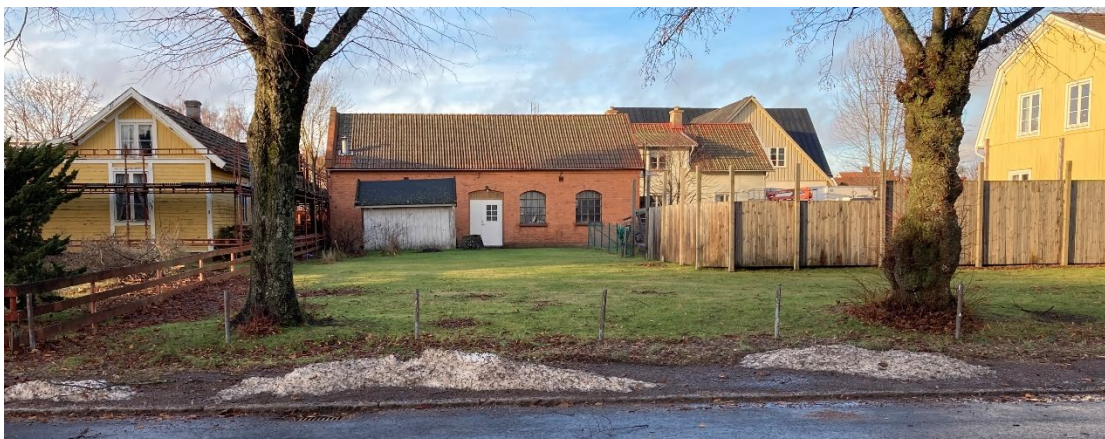
Vy från Nygatan. Verkstadsbyggnaden i tegel mitt i bilden. Gårdshuset Kråkan 2 till vänster
