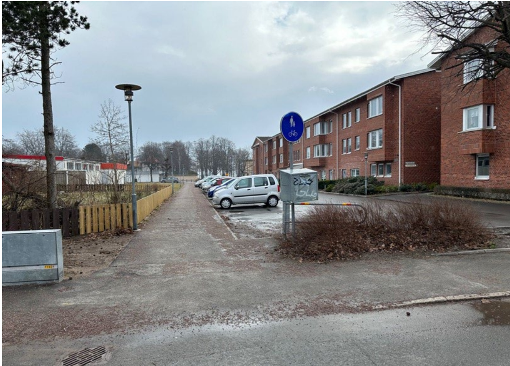
Fredsgatans förlängning med gångväg mot öster, sedd från Viktoriagatan
