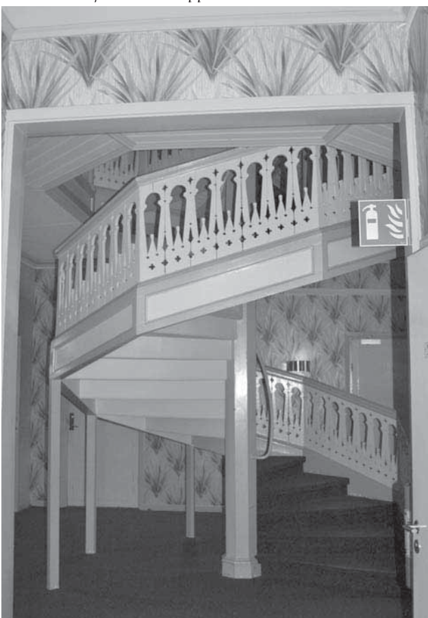
Entréhallens fristående trappa.
