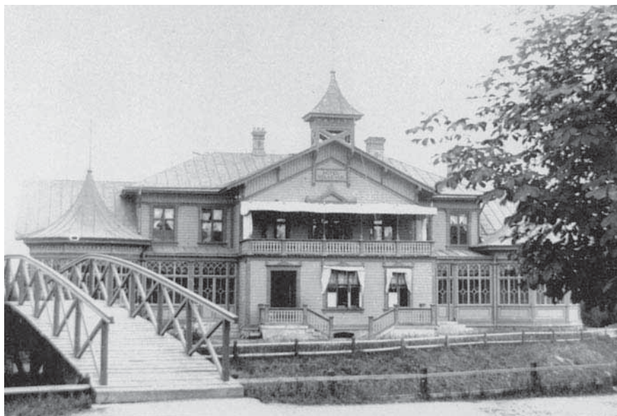
Restaurang Bellevue, mot väster. I förgrunden gångbron över schaktet där järnvägen ned till hamnen går fram.
