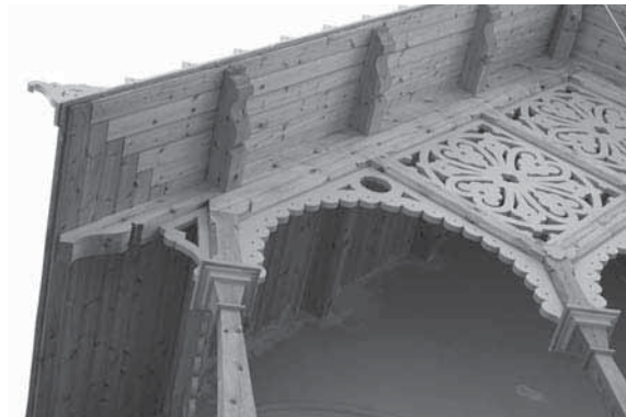
Rekonstruktionsarbetet som påbörjades 2004 har inneburit utvecklad kunskap om epokens trähantverk.
