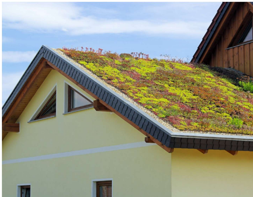
Figur 19. Foto på grönt sedumtak. Källa: Haninge kommun.
