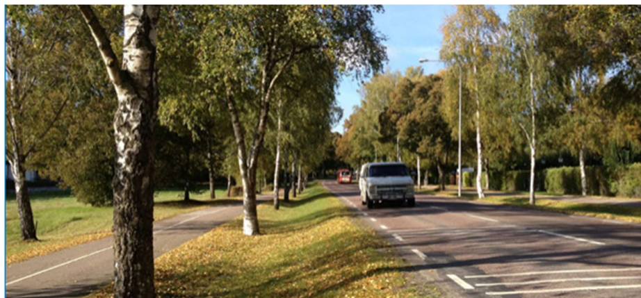
Figur 21. Foto som visar svackdike invid väg. Källa: Haninge kommun.
