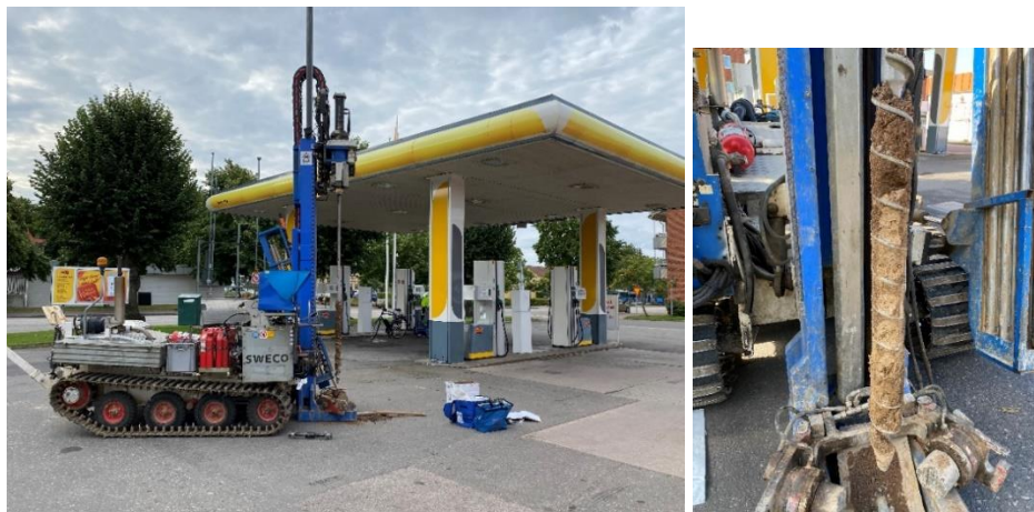
Figur 3: Jordprovtagning med borrhandsvagn i provpunkt 21GA11 (vänster) samt borrhandsvagn med naturlig sand och ovanlagrade fyllnadsmaterial i samma provpunkt (höger).
