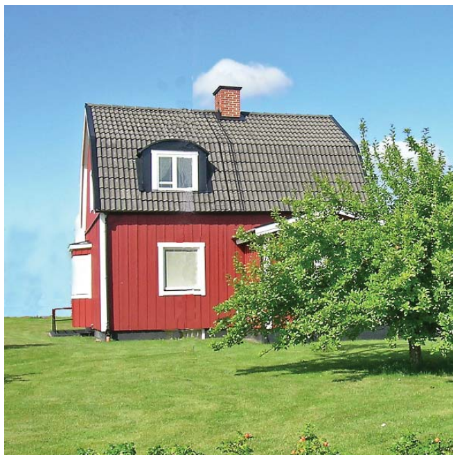
Det befintliga bostadshuset i planområdets östra del.
